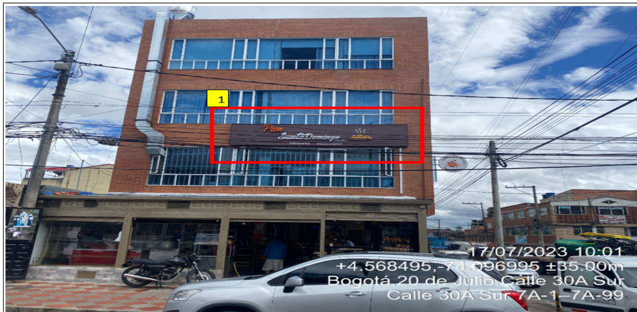
Fachada sobre la CR 7 A del establecimiento comercial PANIFICADORA SANTO DOMINGO CAFETERÍA Y PASTERERÍA , en la cual se observa: un elemento publicitario el cual se encuentra adosado o suspendido en antepecho superior al segundo piso identificado con el numero (1).
